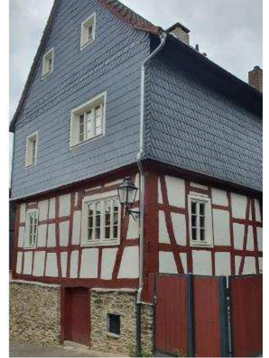
Fertigstellung Modernisierung (Vordere Erbisgasse)
