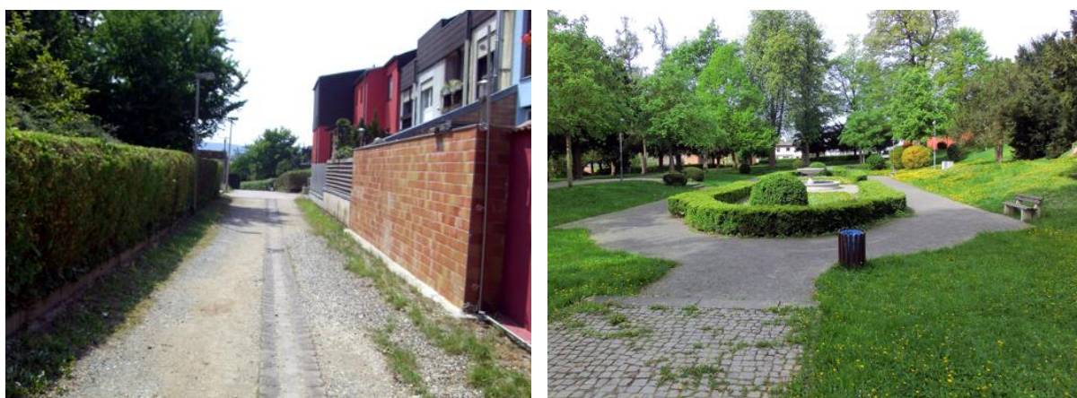
Abb. 66: Weg mit Erneuerungsbedarf, veraltete und unattraktive Möblierung und Beleuchtung im Schlossgarten
