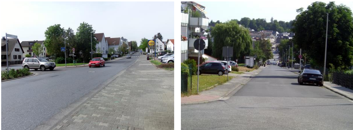
Abb. 63: Bestehende Situation in der Bahnhofstraße
