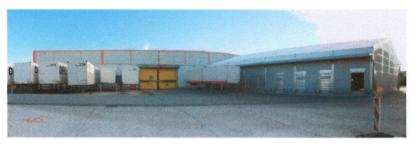
Isolierte Leichtbauhalle auf Asphaltboden (Parkplatz) zur Nutzung als Erweiterung eines Verteilzentrums. Installation von 20 Rolltoren, Rammschutz und Vordach für eine optimale Funktionalität. Anbindung an Stahl-Beton-Bestandshalle über eine Geibelwand, sodass die bauseitige Fördertechnik nahtlos von Halle zu Halle führen kann.
