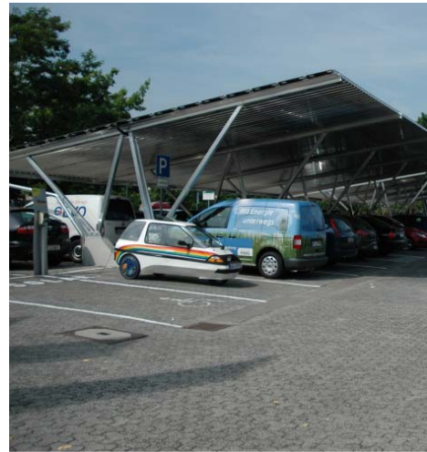
Abb. 9: Solar-Carport auf dem Firmengelände der Energieversorgung Offenbach AG (EVO), © EVO
