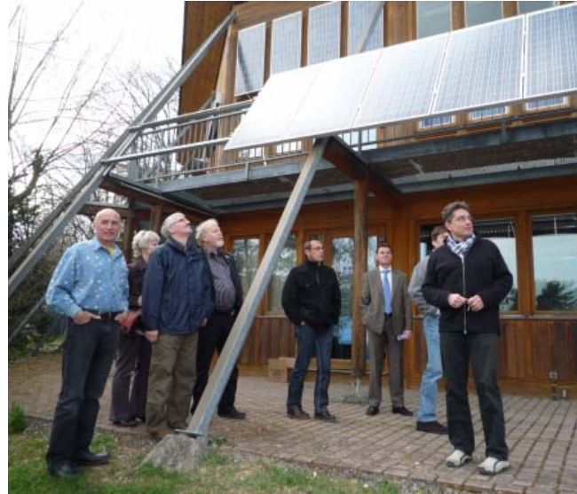
Abb. 13: Technikerschule in Butzbach: Vorgelagerte Bauelemente erlauben die energetische Nutzung der Sonneneinstrahlung und gewährleisten zugleich Verschattung im Hochsommer, © Umweltforum Rhein-Main e.V. 2010
