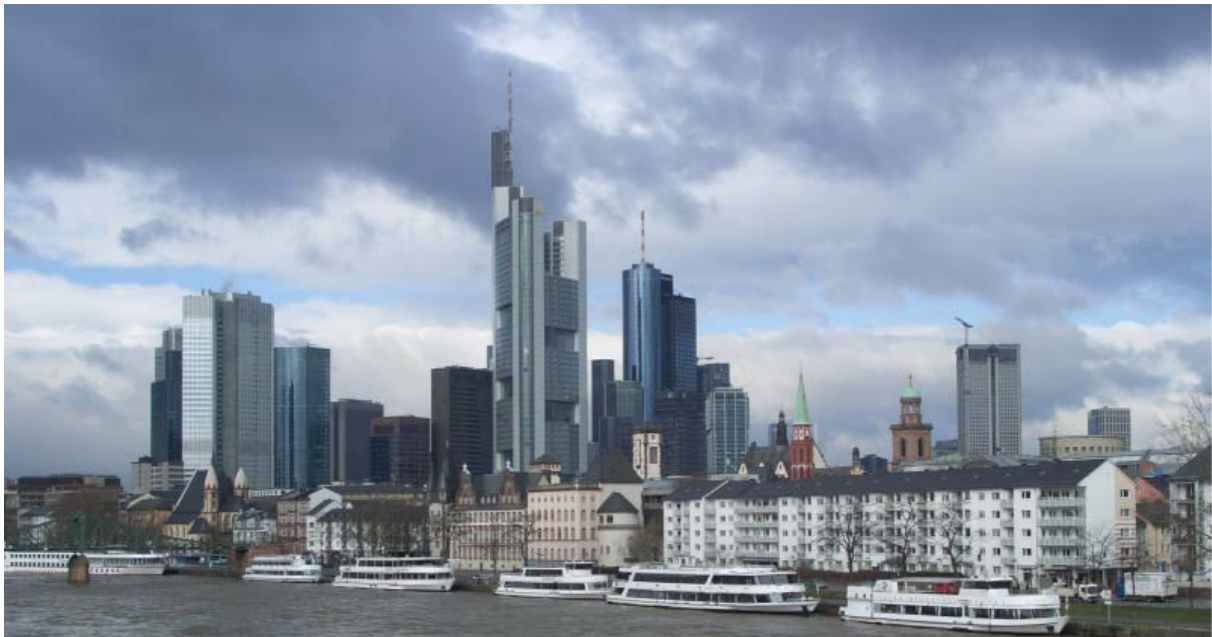
Abb. 4: Frankfurt am Main (© DWD): Der Blick über den Main auf die Innenstadt und das Bankenviertel zeigt die große Vielfalt der Bebauungsstrukturen. Die Berechnung der städtischen Wärmebelastung erfordert daher eine detaillierte und räumlich hoch aufgelöste Simulation des Stadtklimas.
