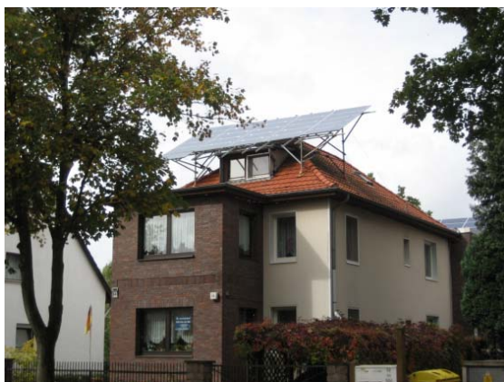
Abb. 24: Ob diese Konstruktion den nächsten Sturm übersteht? © Firma Roto Dach- und Solartechnologie GmbH
