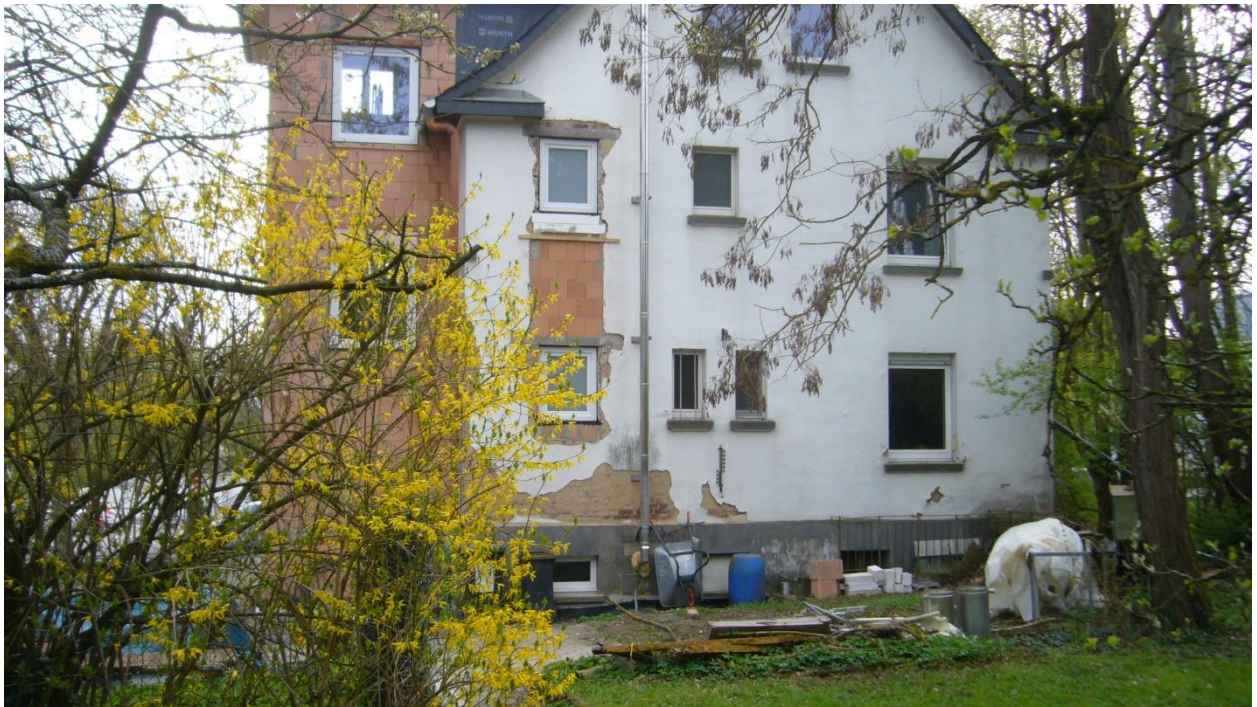
Foto 10 Im Umbau befindliches Wohnhaus an der Hattsteiner Allee
