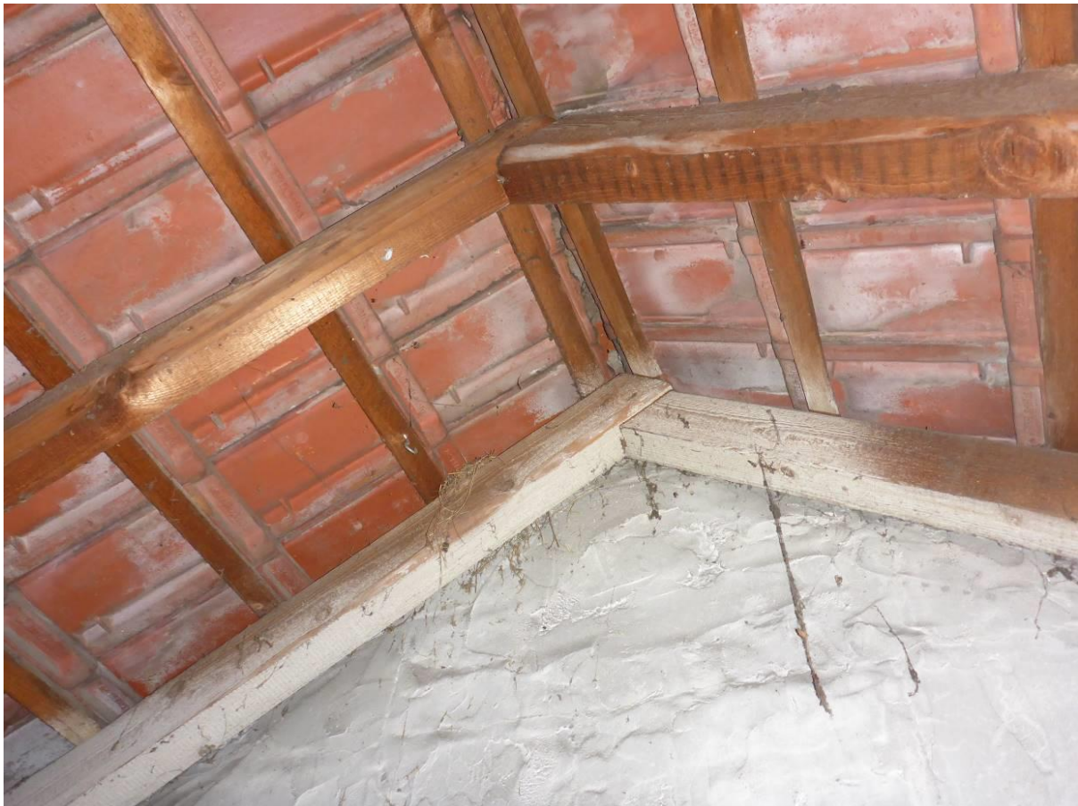
Abb. 4: Im Bereich der Giebelinnenseiten (Sparren und Außenwand) fanden sich Nester vom Haussperling, jedoch keine Hinweise (Kot) auf die Besiedlung durch Fledermäuse
