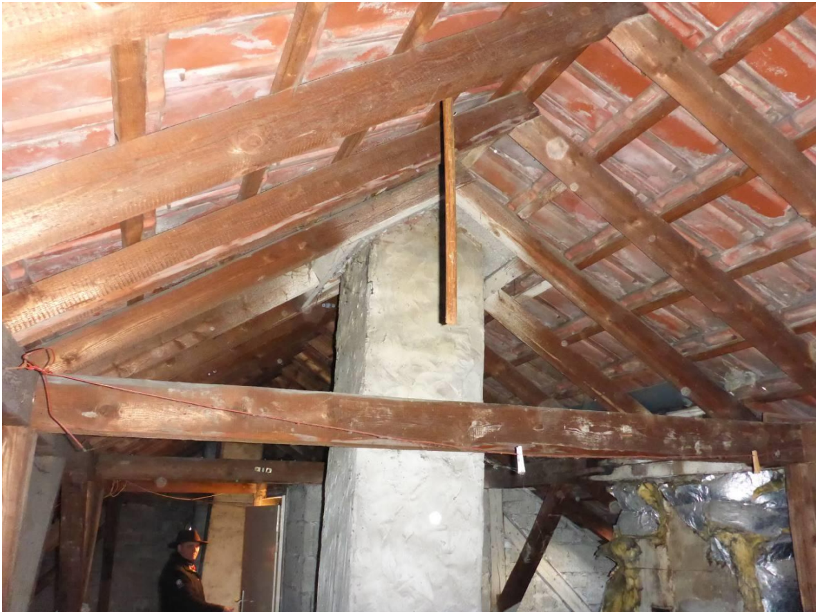
Abb. 9: In den gut übersichtlichen Dachböden fanden sich weder auf den Kehlbalcken noch auf dem Boden oder in potenziellen Quartierbereichen Hinweise auf Fledermäuse.
