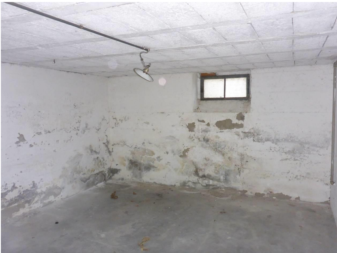
Abb. 12: Die Keller sind zu warm für eine Besiedlung winterschlafender Fledermäuse und hermetisch verschlossen.
