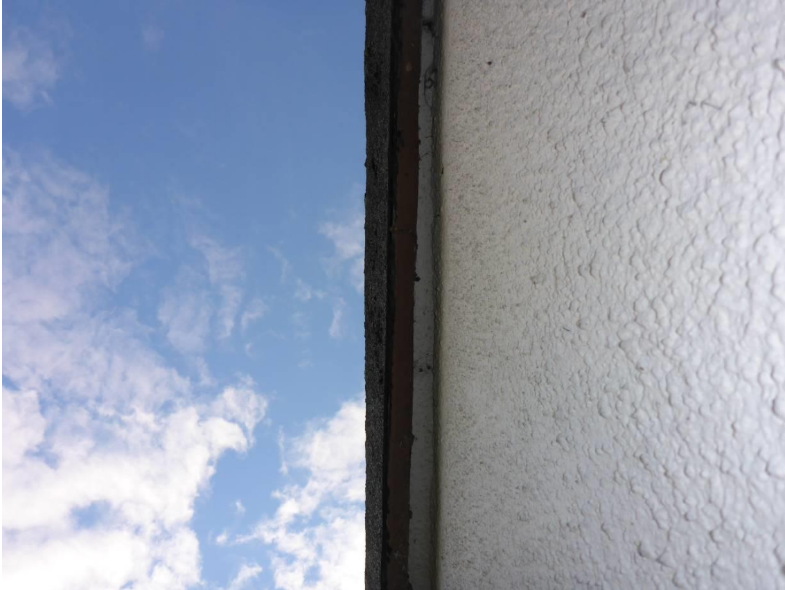
Abb. 13: Dachüberstand an einer der Garagen ohne Eignung als Lebensstätte für Fledermäuse
