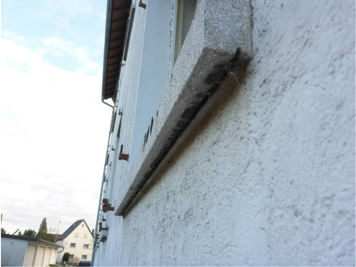
Abb. 15: Im Bereich der Fensterbänke fanden sich keine potenziellen Lebensstätten
