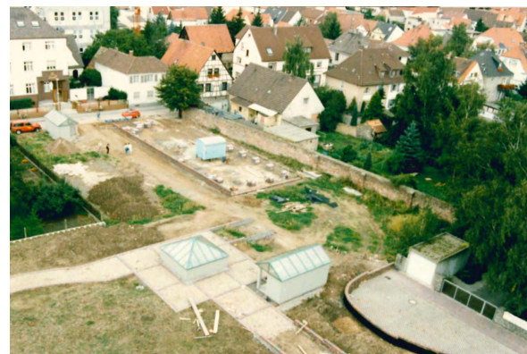
Während der Umbauarbeiten
