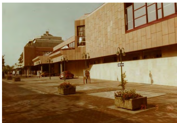
Hallenbad kurz nach Fertigstellung der Schulstraße
