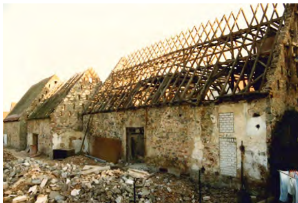
Zustand vor Modernisierung und Umbau
