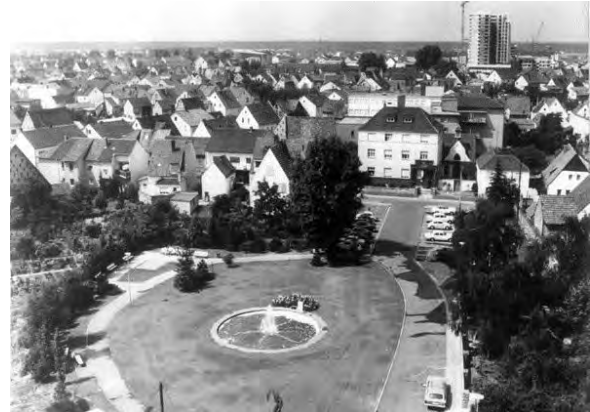
Spitalplatz vor Umbau
