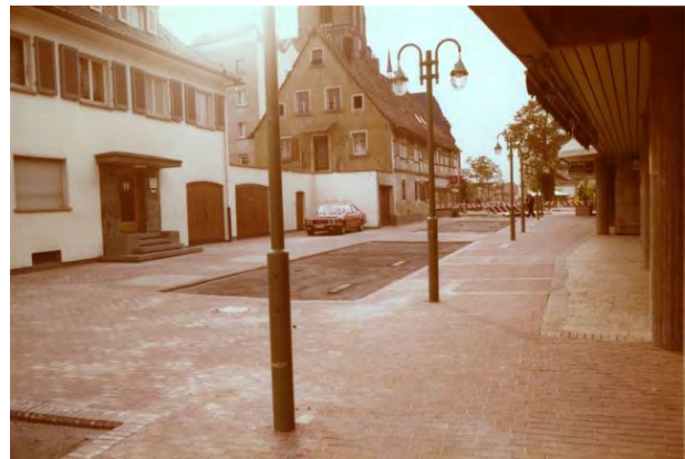
Schulstraße während des Umbaus
