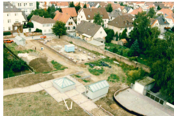
Während der Umbauarbeiten
