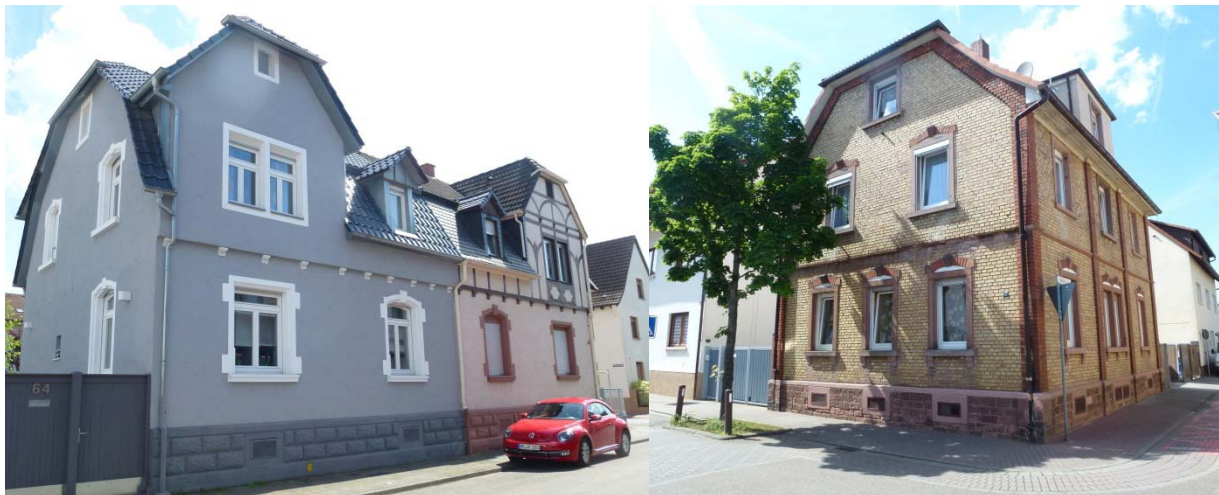
Abb. 6: Historische und erhaltenswerte Bausubstanz im UG. (Quelle: Fotodokumentation)
