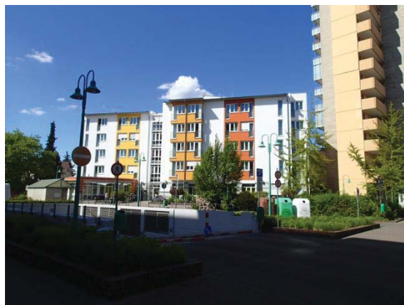
Neuere Bebauung Spitalplatz 1, Rathausstraße 53 und 55. Einfahrt der Tiefgarage im Vordergrund
