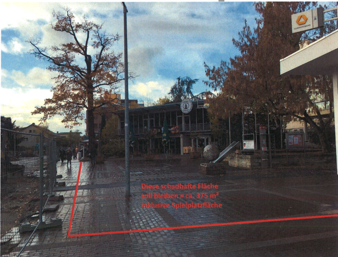
03 Fläche vor Stufen Rathaus IMG_0025.JPG
