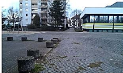
Bürgerhausumfeld - Zugänglichkeit verbessern, Mängel beseitigen
