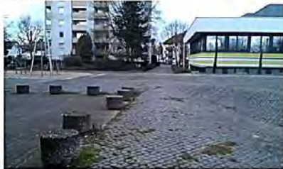
Bürgerhausumfeld - Zugänglichkeit verbessern, Mängel beseitigen
