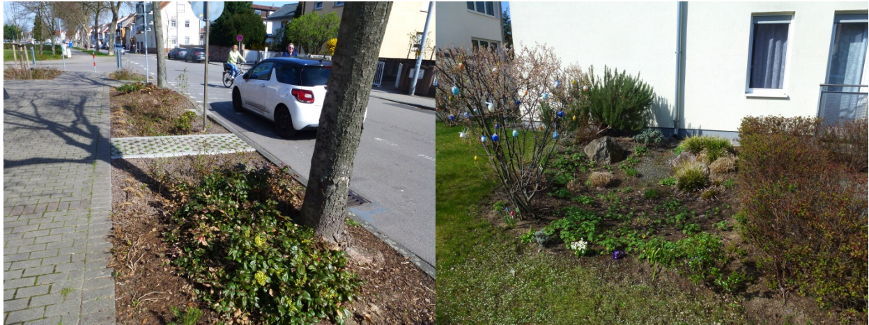
Abb. 26: Versickerungsmulden im UG im öffentlichen Straßenraum (li.), auf Privatgrundstück. (Quelle: Fotodokumentation)
