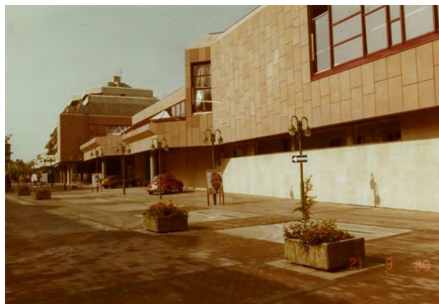
Hallenbad kurz nach Fertigstellung der Schulstraße
