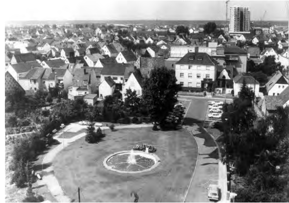
Spitalplatz vor Umbau
