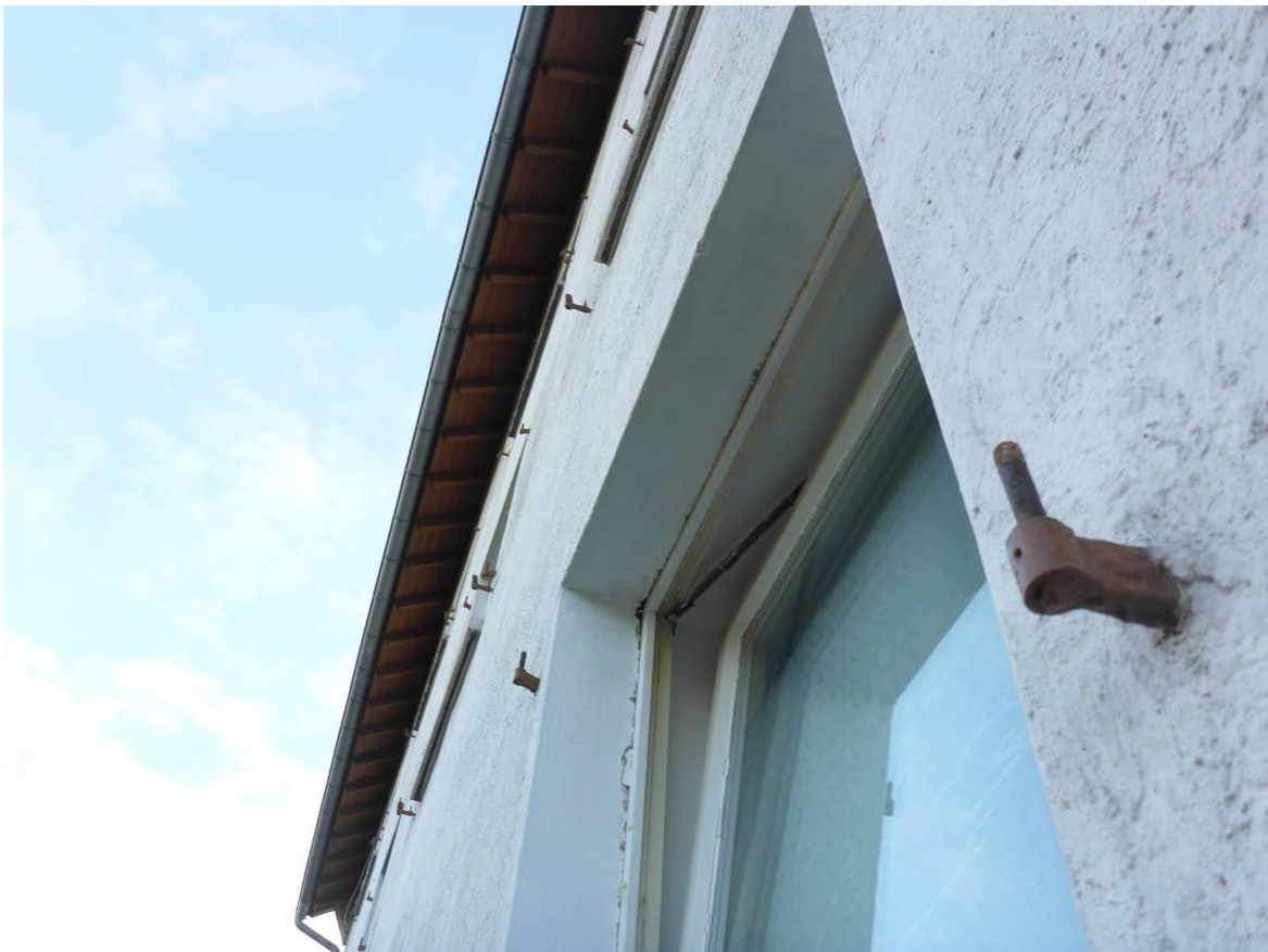
Abb. 16: Auch im Bereich der Fenster fanden sich aufgrund des Fehlens von Rollladenkästen und Fensterrahmen keine möglichen Spaltenquartiere für Fledermäuse.
