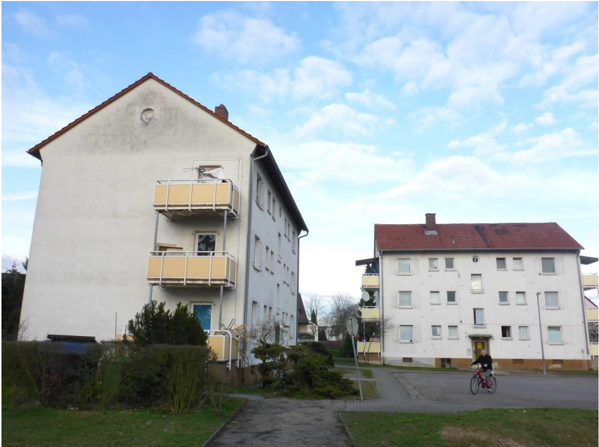
Abb. 1: Franz-Schubert-Str. 7 (links) und Nr. 5 (rechts) in 50er-Jahre-Bauweise
