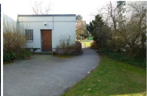
Anbau mit Toilette
