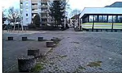
Bürgerhausumfeld - Zugänglichkeit verbessern, Mängel beseitigen
