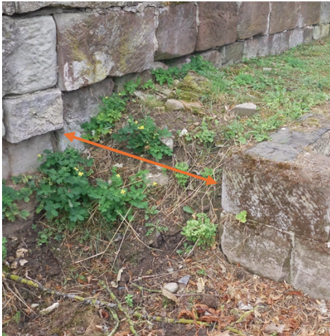
5 – Lücke zwischen den Mauern
