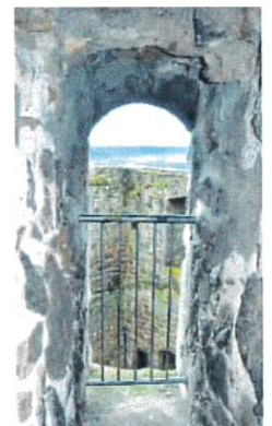
Das Mauerwerk soll saniert, das Umfeld für den Tourismus attraktiver werden.
