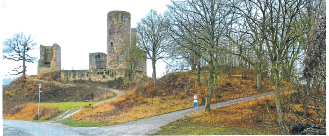
Die Kugelsburg Volkmarsen wird als touristisches Ziel attraktiver gestaltet werden. Das Mauerwerk benötigt eine Sanierung.
