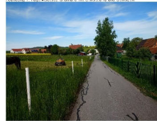
Abbildung 3: Asphaltierter Feldweg und angrenzende Garten
