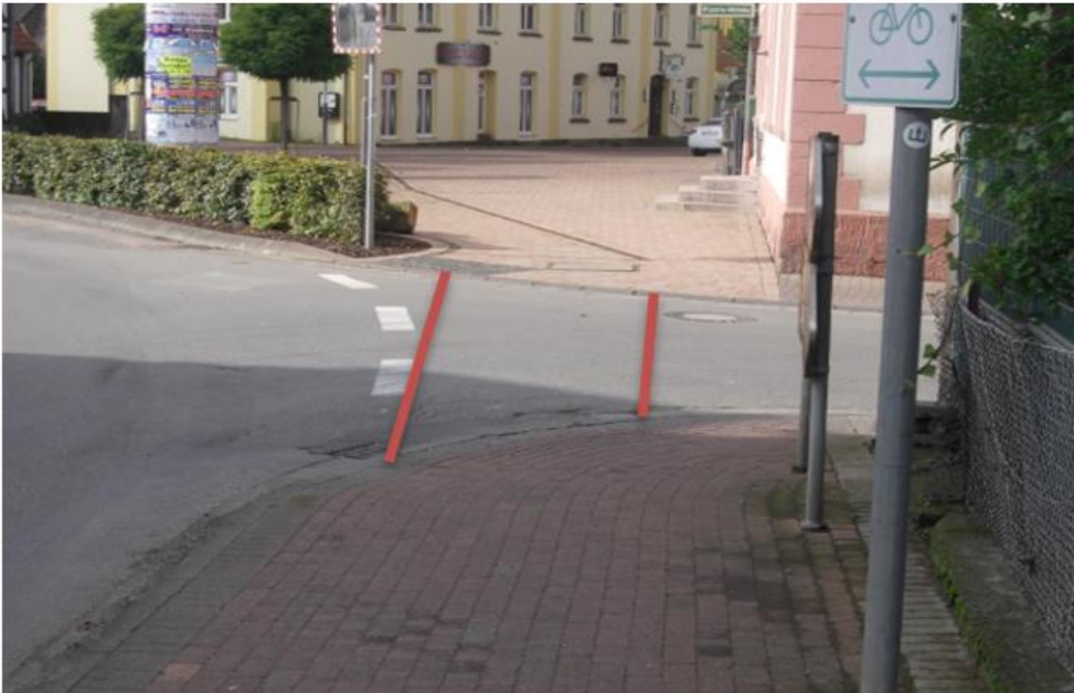
Bild 94: Radwegende mit anschließendem kurzem Radfahrstreifen zum gefahrlosen Überleiten
