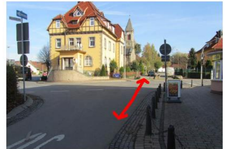
Bild 3: Blick aus der Wittmarstraße auf die fehlende RV-Schleuse. Seitlich im Einmündungsbereich der Wittmarstraße ist eine geschützte Aufstellfläche mit separater Fahrradampel zu schaffen.
