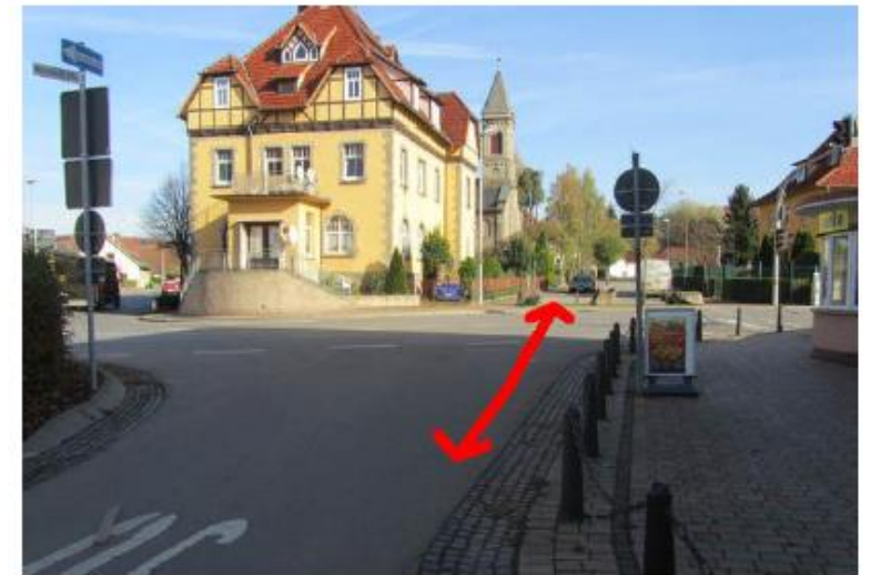
Bild 3: Blick aus der Wittmarstraße auf die fehlende RV-Schleuse. Seitlich im Einmündungsbereich der Wittmarstraße ist eine geschützte Aufstellfläche mit separater Fahrradampel zu schaffen.
