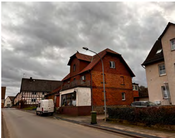
Bild 39: Blick in die Straße Lützer Weg
