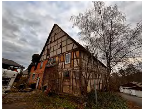
Bild 34: Wirtschaftsgebäude in der Straße Spulkater
