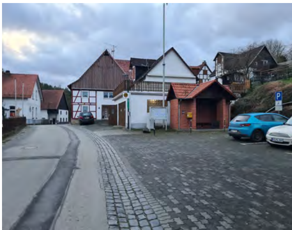
Bild 28: Blick in die Straße Oberdorf
