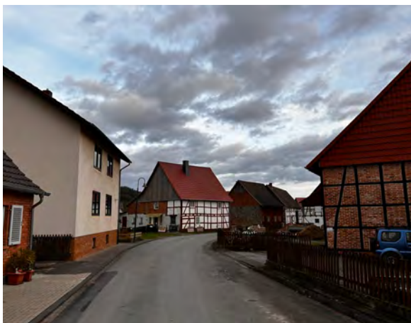
Bild 21: Blick in die Straße Zum Hellenberg
