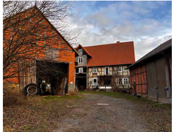
Bild 32: Wohn- und Wirtschaftsgebäude in der Straße Kirchenweg
