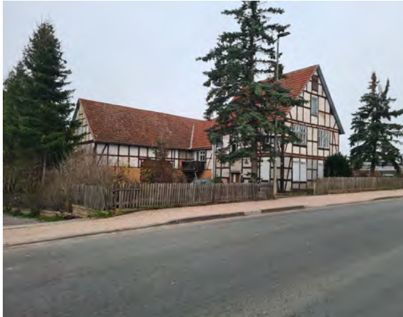
Bild 59: Wohn- und Wirtschaftsgebäude in der Warburger Straße
