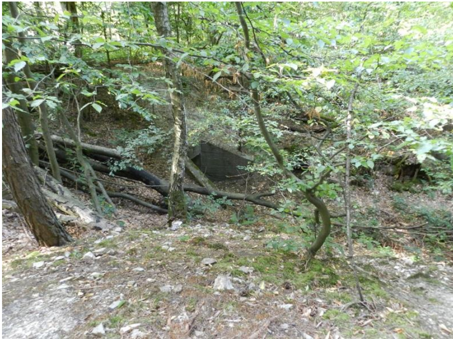
Abbildung 8: Mögliche Stelle für eine Wasserrückhaltung am Fahrenbach
