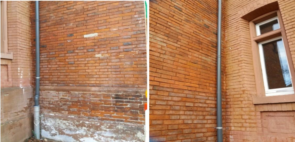
Im Ergebnis wurden nach dem Abbeizen starke Verwitterungen am Mauerwerk und Sandstein sowie Zementplomben im Mauerwerk erkennbar. Auch konnten die angenommen auszutauschenden Sandsteine verifiziert/ermittelt werden. Zudem sind die Holzfenster in Anschlussbereichen der Sohlbank defekt.
