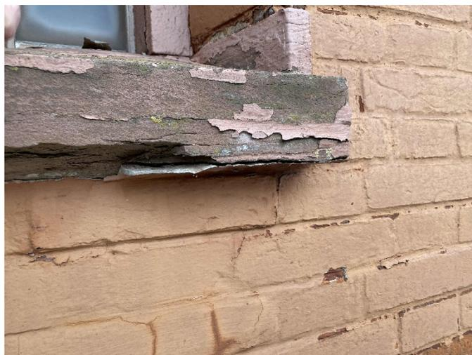
Für den Eingangsturm, bestand akuter Handlungsbedarf durch herabfallende Gesimse. Es erfolgte die Einrüstung des Turmbereichs die Gerüststellung und das Abbeizen der Fassade, sowie die Sichtung der Sandsteine durch einen Steinmetz.
